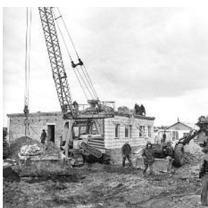
● Строительство двухквартирного дома в с. Верх-Тула
