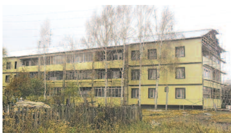
● Был произведен капремонт одного дома в Верх-Туле и одного – в п. Тулинский. Еще в одном доме в Верх-Туле заменили кровлю
