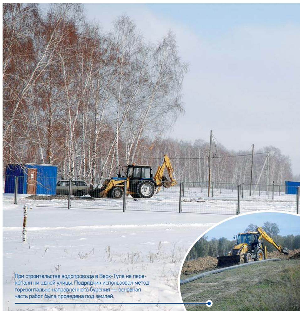
При строительстве водопровода в Верх-Туле не перекопали ни одной улицы. Подрядчик использовал метод горизонтально направленного бурения — основная часть работ была проведена под землей.
