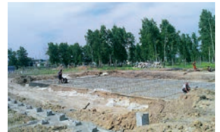
● ОАО «Тулинское» ведёт работы по строительству резервуаров чистой воды
