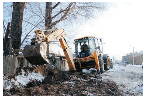
● Работы по реконструкции дороги предусматривают и устройство ливневой канализации для сбора воды
