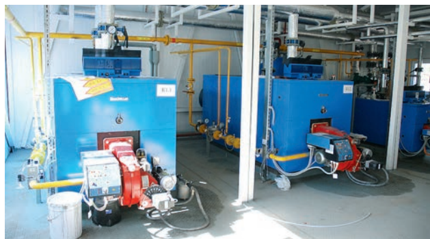
● Вместо старой малоэффективной котельной в п. Тулинский в 2014 году построена новая модульная газовая котельная
