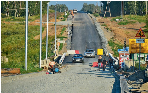
● Движение по мосту через р. Тула открыли 2 августа
