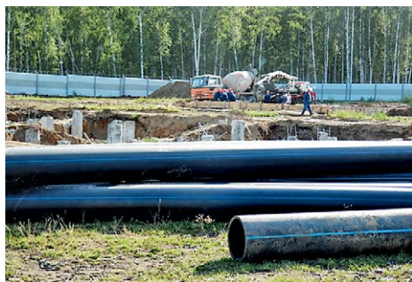
● Работы по подпрограмме «Чистая вода» позволили вывести из эксплуатации большую часть старых скважин
