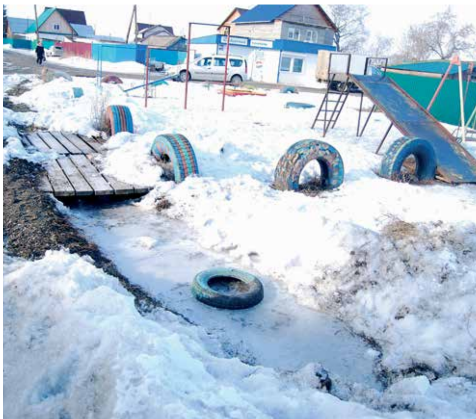
● Система дренажа и водоотвода паводковых вод, позволяющая им естественным образом пройти под землей без разлива на поверхности, в настоящее время смонтирована во всех точках понижения рельефа.
