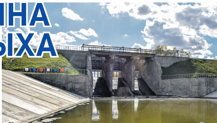
● После ремонта ГТС будет обеспечивать стопроцентную безопасность во время паводка
