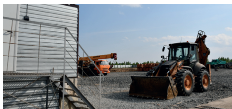
● Возле новой школы началась еще одна стройка
