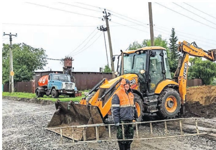
● Новый водопровод длиной 615 метров соединили с центральной водопроводной системой села
